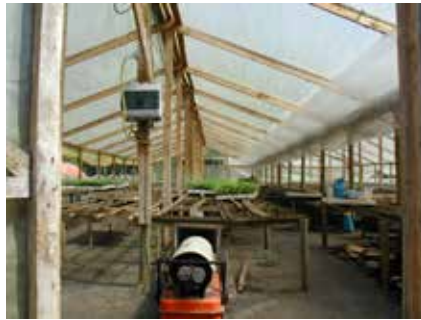
Figura 5.7. Sistema de calefacción con aire forzado caliente.
